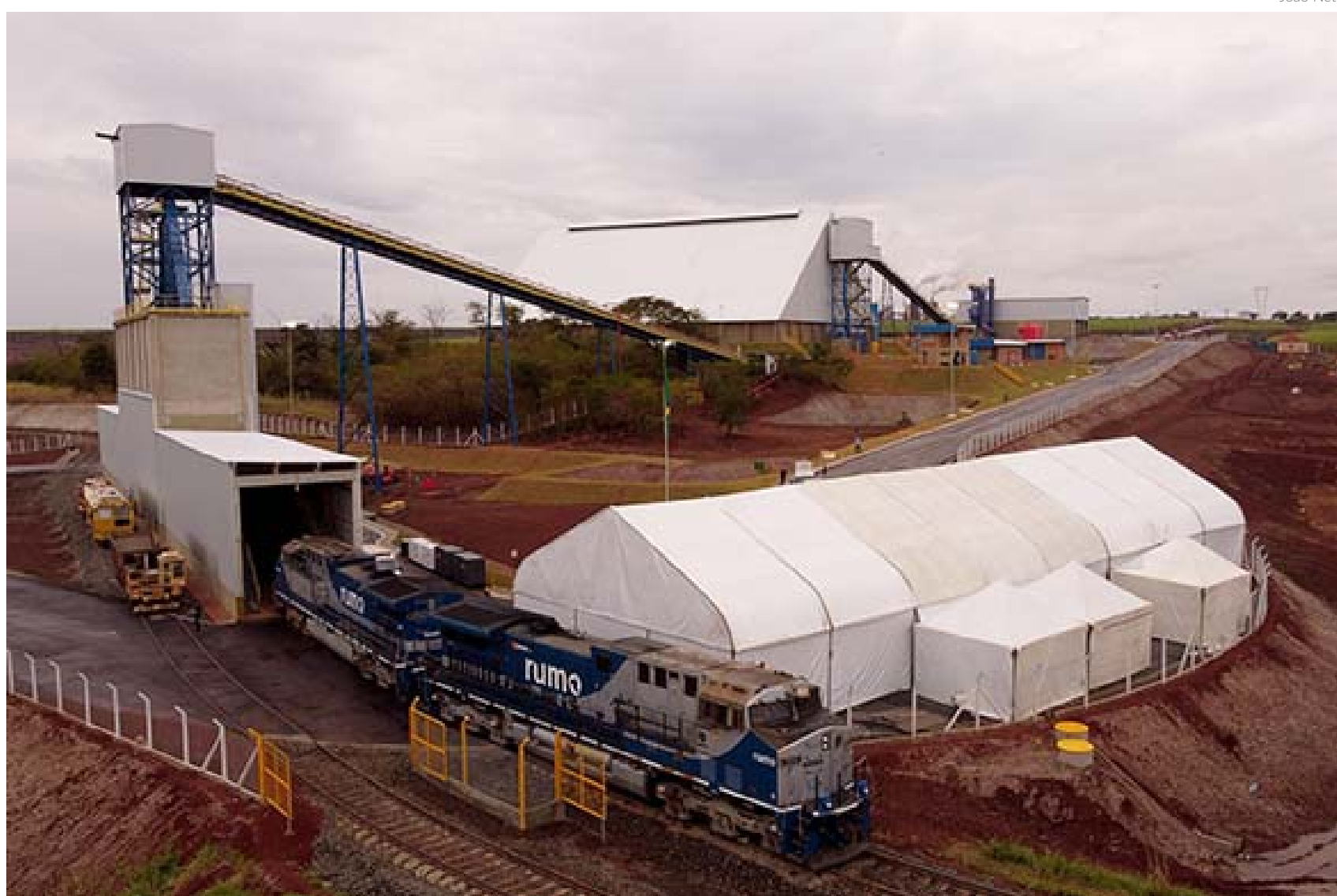
O terminal poderá receber até 10 mil toneladas por dia, o que equivale a 300 caminhões/dia.
