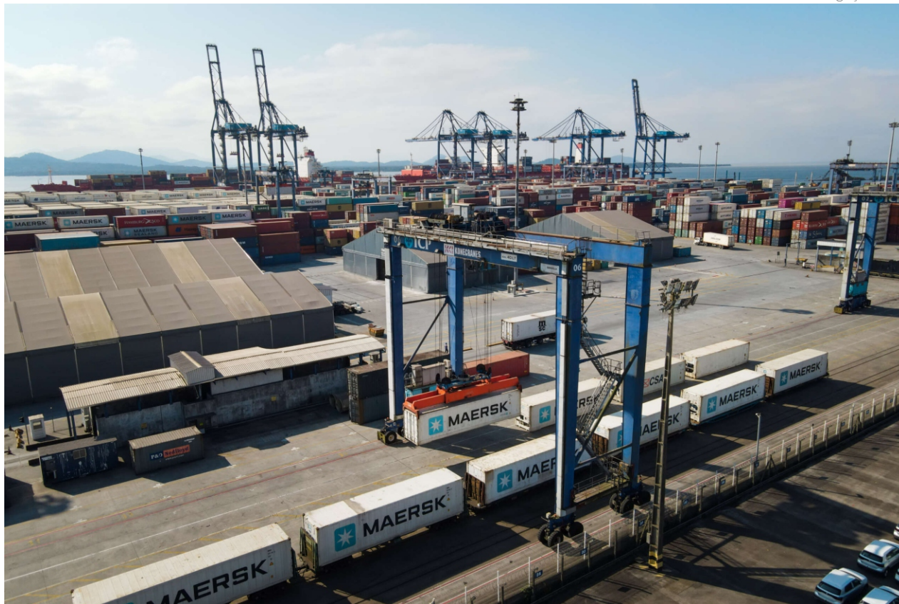
Está prevista também a expansão de 43% da área destinada aos contêineres refrigerados, com a instalação de 5.178 tomadas. As carnes congeladas estão entre as principais cargas operadas pelo terminal.
