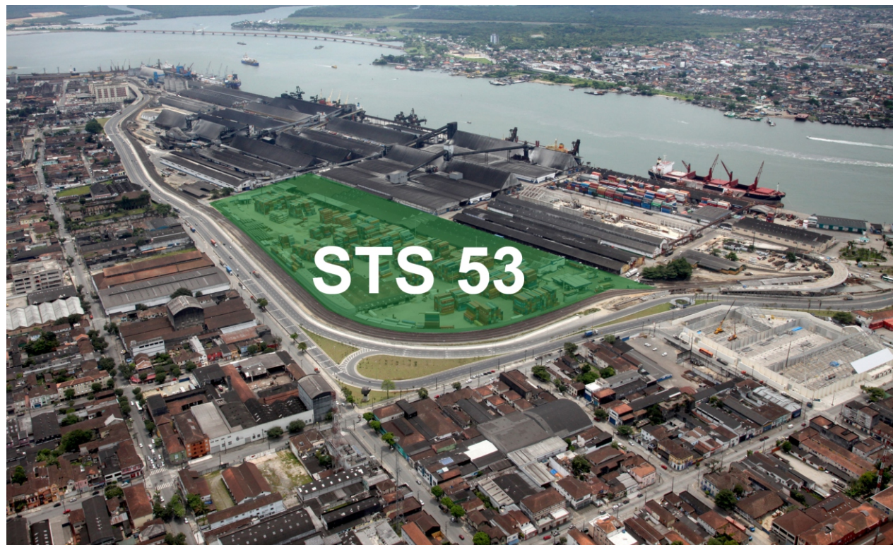
O STS 53 é destinado à movimentação e armazenagem de granéis sólidos minerais, especialmente fertilizantes e sulfatos em área de 87,9 mil m 2
