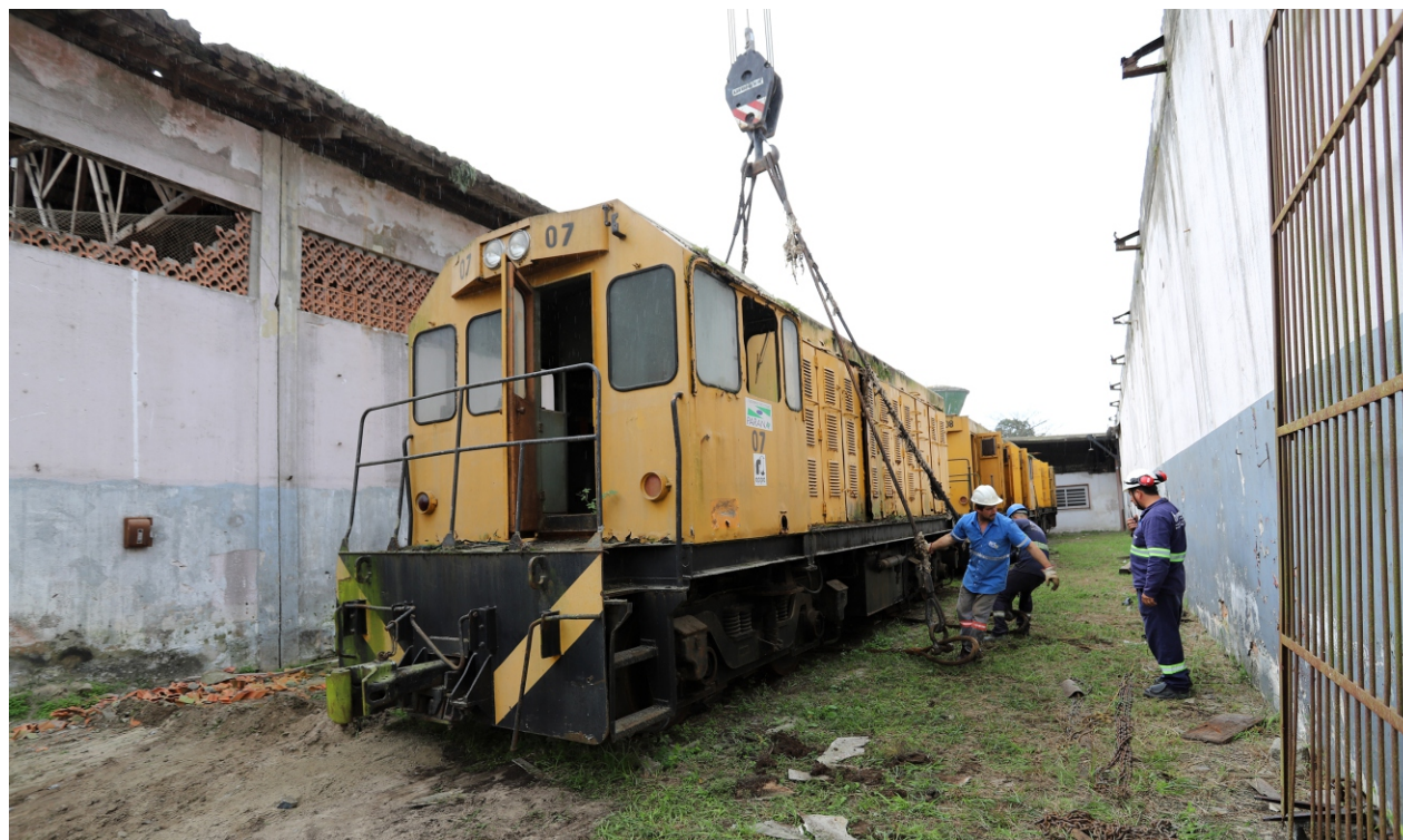
Um muro precisou ser derrubado e um guindaste com contrapesos foi instalado para erguer as locomotivas, que pesam cerca de 58 toneladas cada
