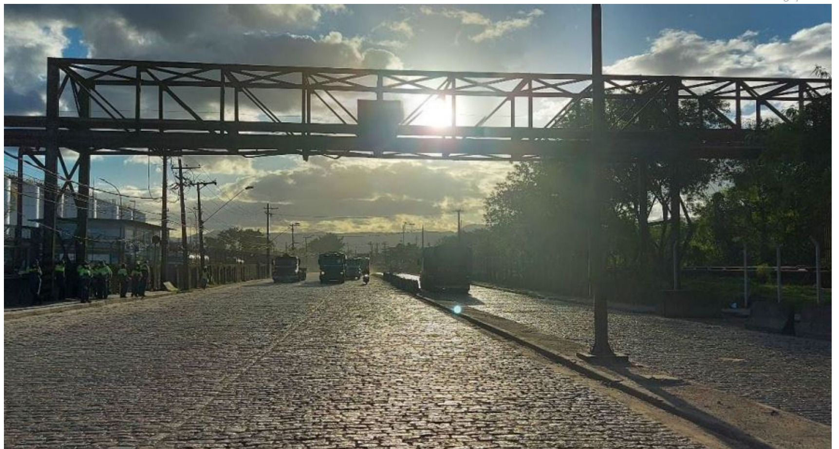
Obras são realizadas no trecho entre o Viaduto Paulo Benevides e a instalação da Brasil Terminal Portuário, na região da Alemoa
