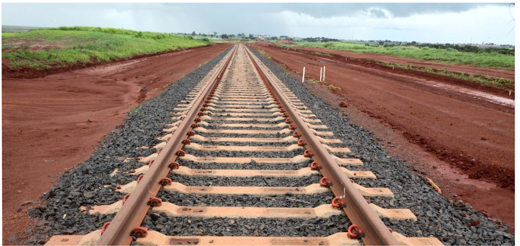
A extensão que passará por Mato Grosso do Sul também deve ser iniciada na primeira etapa das obras, com recurso de R$ 4,7 bilhões
