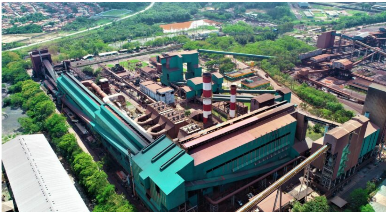
A usina da Vale será conectada à planta de regaseificação no porto por uma rede de distribuição de 4 km
