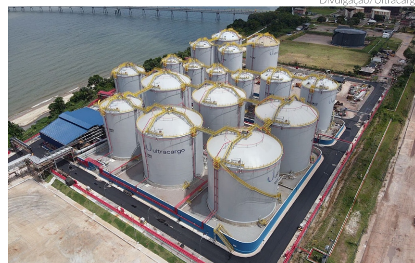
O terminal conta com 17 tanques, totalizando 110 mil metros cúbicos de capacidade, além de um píer com dois berços de atracação e calado de 14 metros
