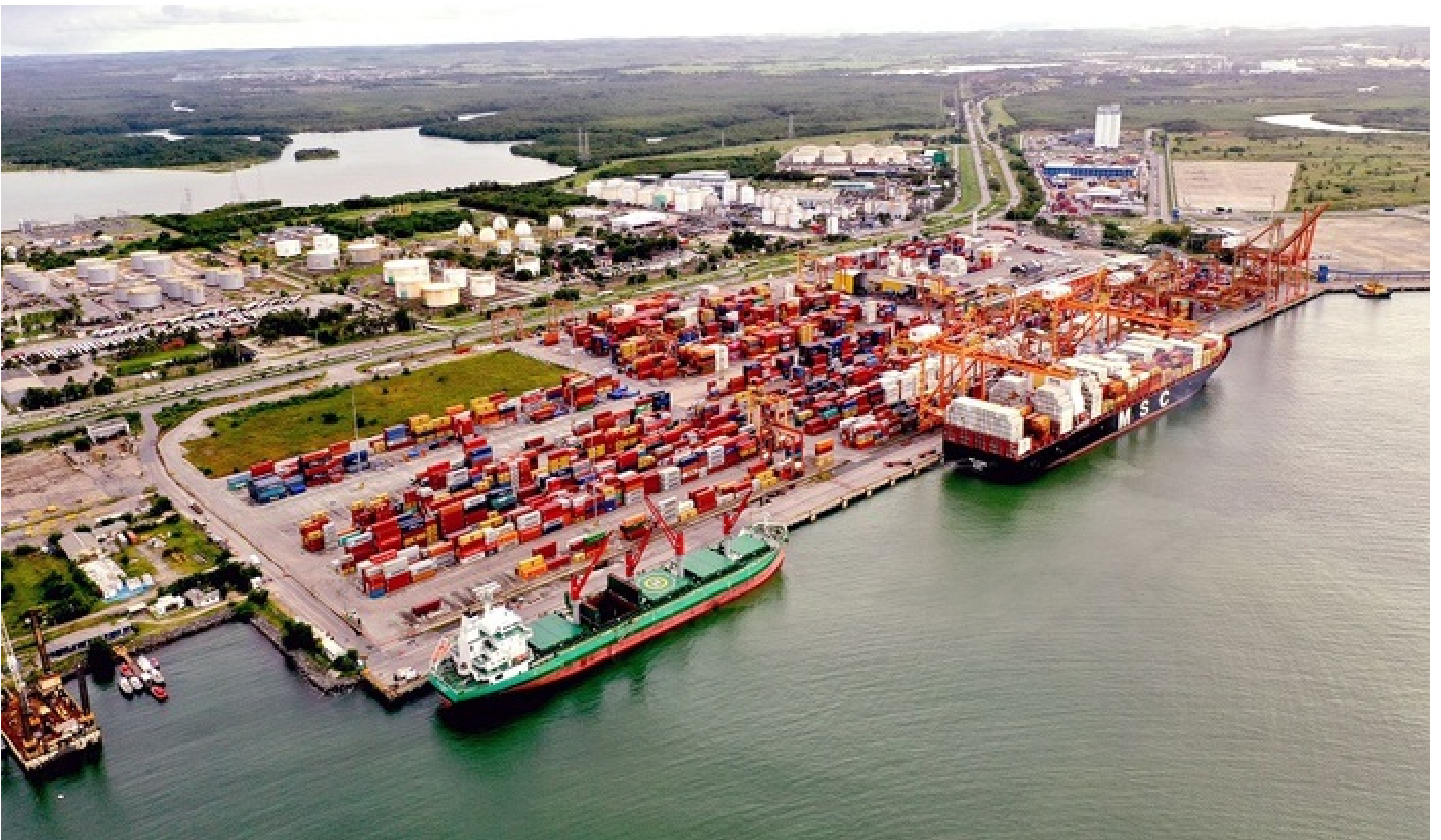
Novo terminal da companhia em Suape acrescentará 55% na capacidade de movimentação de contêineres do complexo portuário
