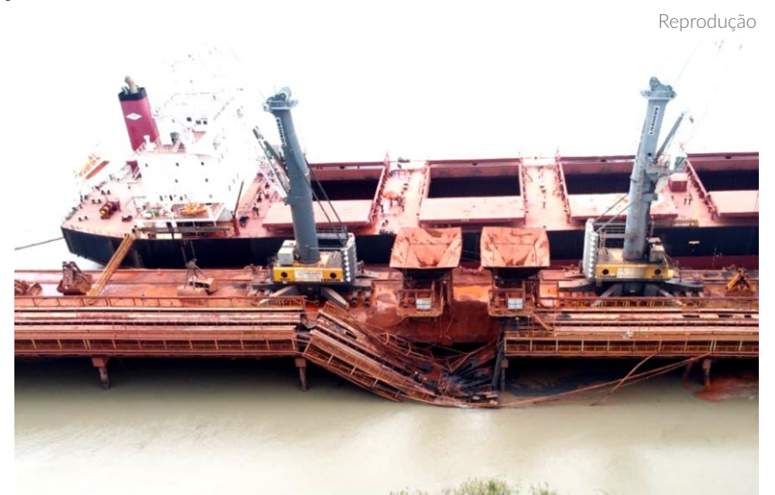
O acidente ocorreu no equipamento que opera no TUP da empresa, em São Luís, no momento em que ocorria um descarregamento de bauxita e outros insumos
