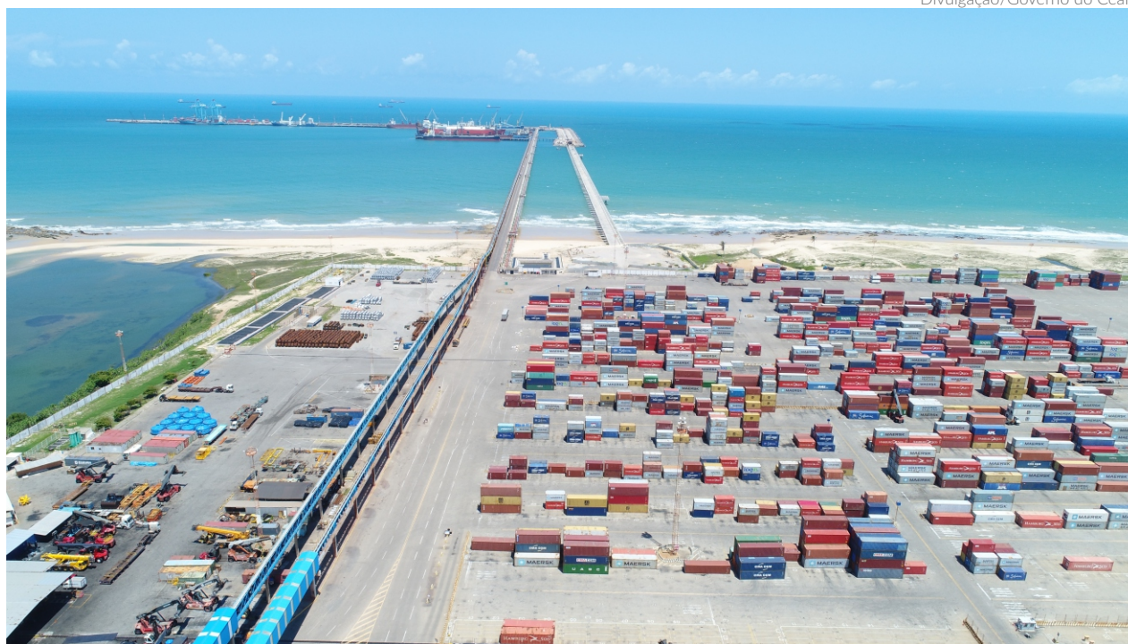
O Porto do Pecém vai ganhar um berço de atracação específico para hidrogênio verde, mas o governador não deu mais detalhes sobre como será a obra de expansão
