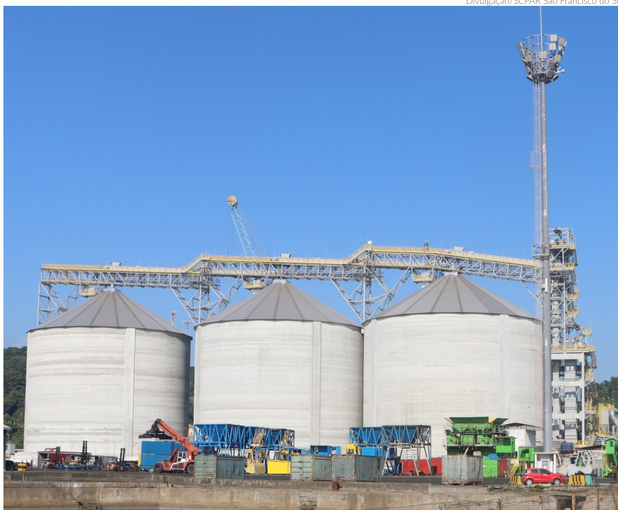
O terminal investiu R$ 250 milhões nos silos e obras complementares
