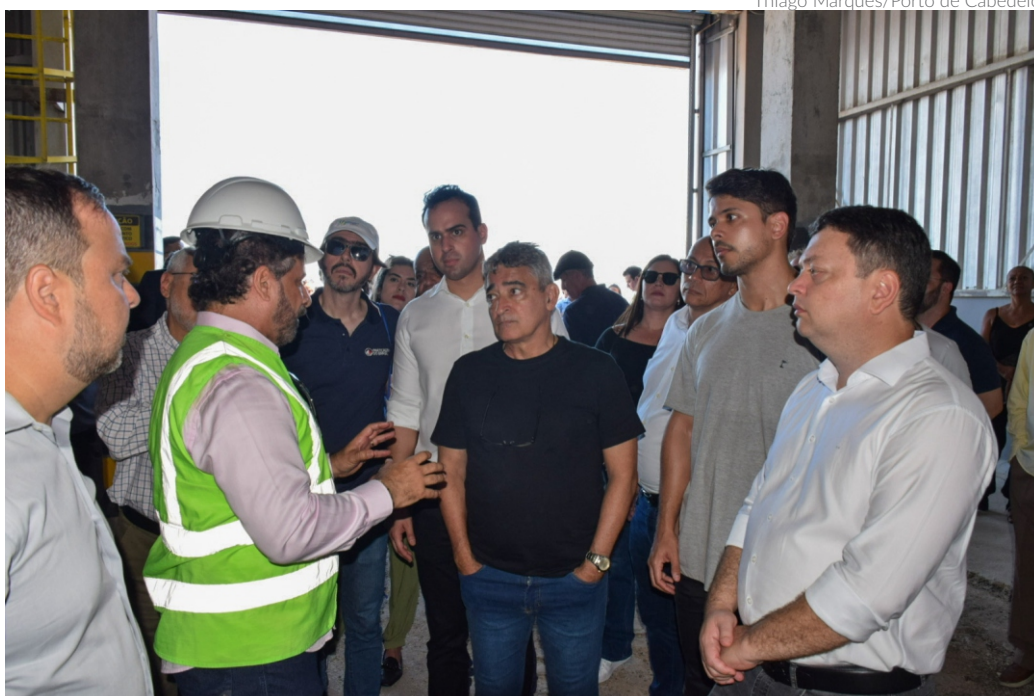
Ainda no Porto de Cabedelo, a comitiva do fórum regional visitou outras instalações, algumas delas em fase de obras
