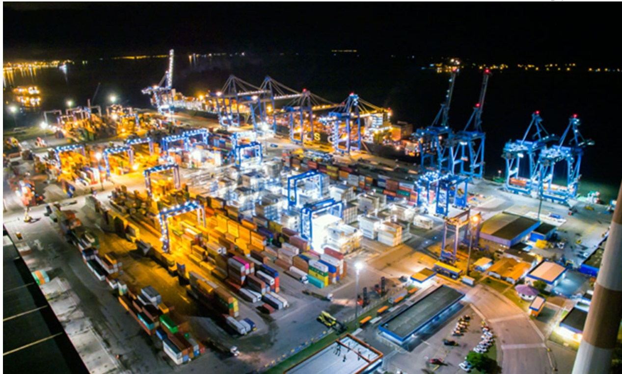
Por meio do novo sistema, toda a energia gerada para o funcionamento do Tecon virá de fontes renováveis que podem ser eólica, solar ou de pequenas centrais hídricas
