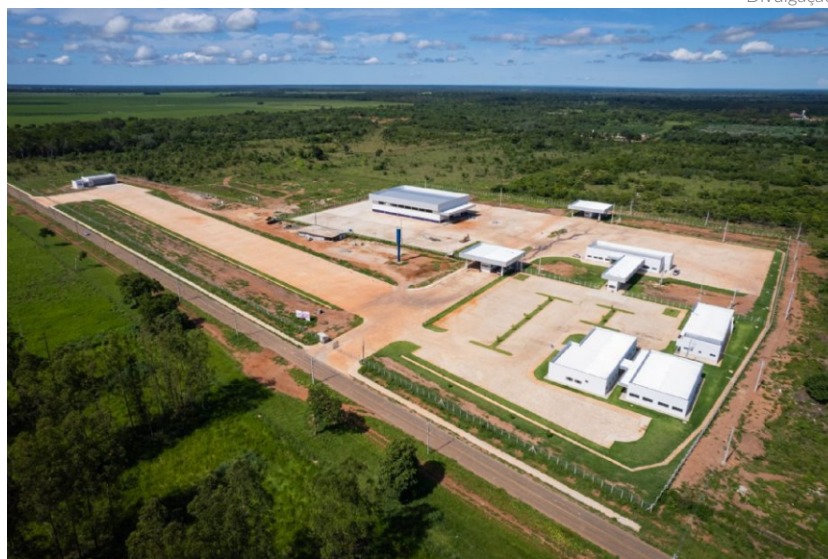
▲ A ZPE de Cáceres tem uma área de aproximadamente 240 hectares e está dividida em cinco módulos, que são os locais onde as empresas se instalarão
