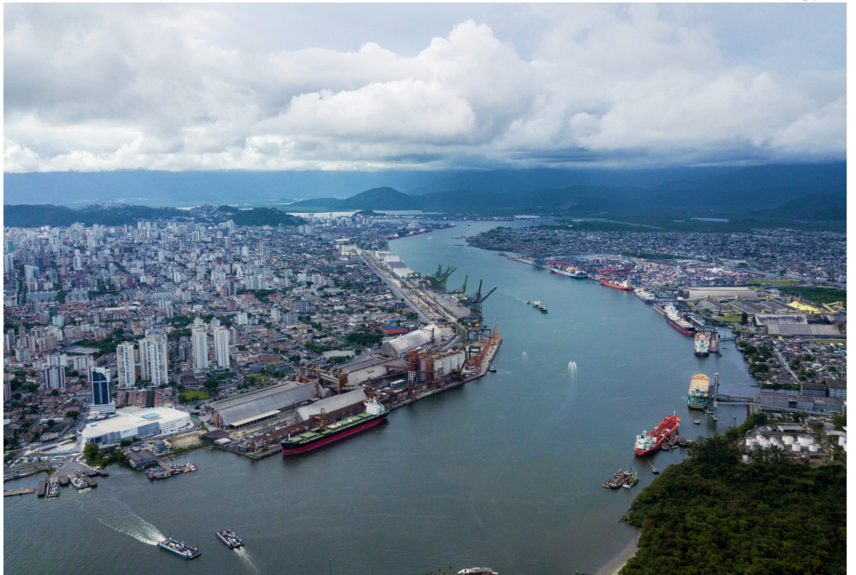
O túnel ligando as margens direita e esquerda do Porto de Santos deverá ter a extensão de 860 metros e a travessia por essa via tem duração estimada em um minuto e meio
