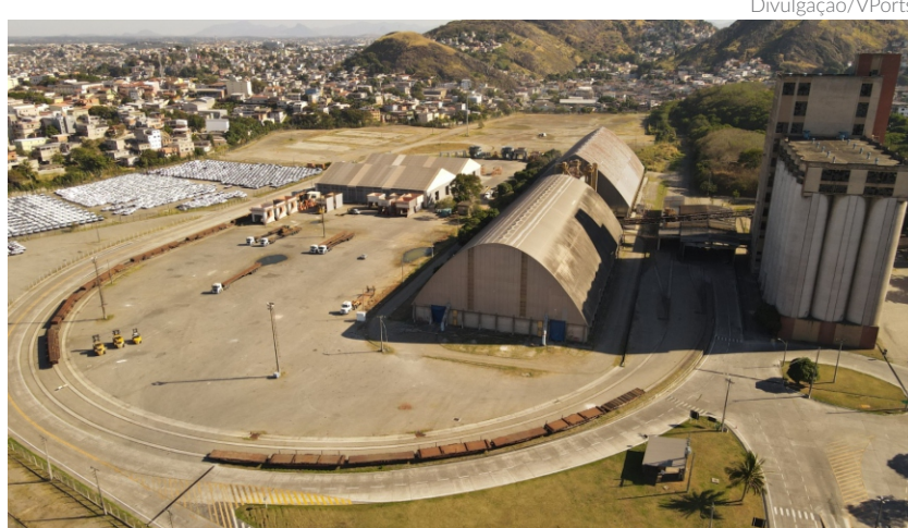
Com mais de 40 mil metros quadrados, a área arrendada pela Multilift será utilizada na armazenagem de granéis sólidos movimentados no Cais de Capuaba, em Vila Velha
