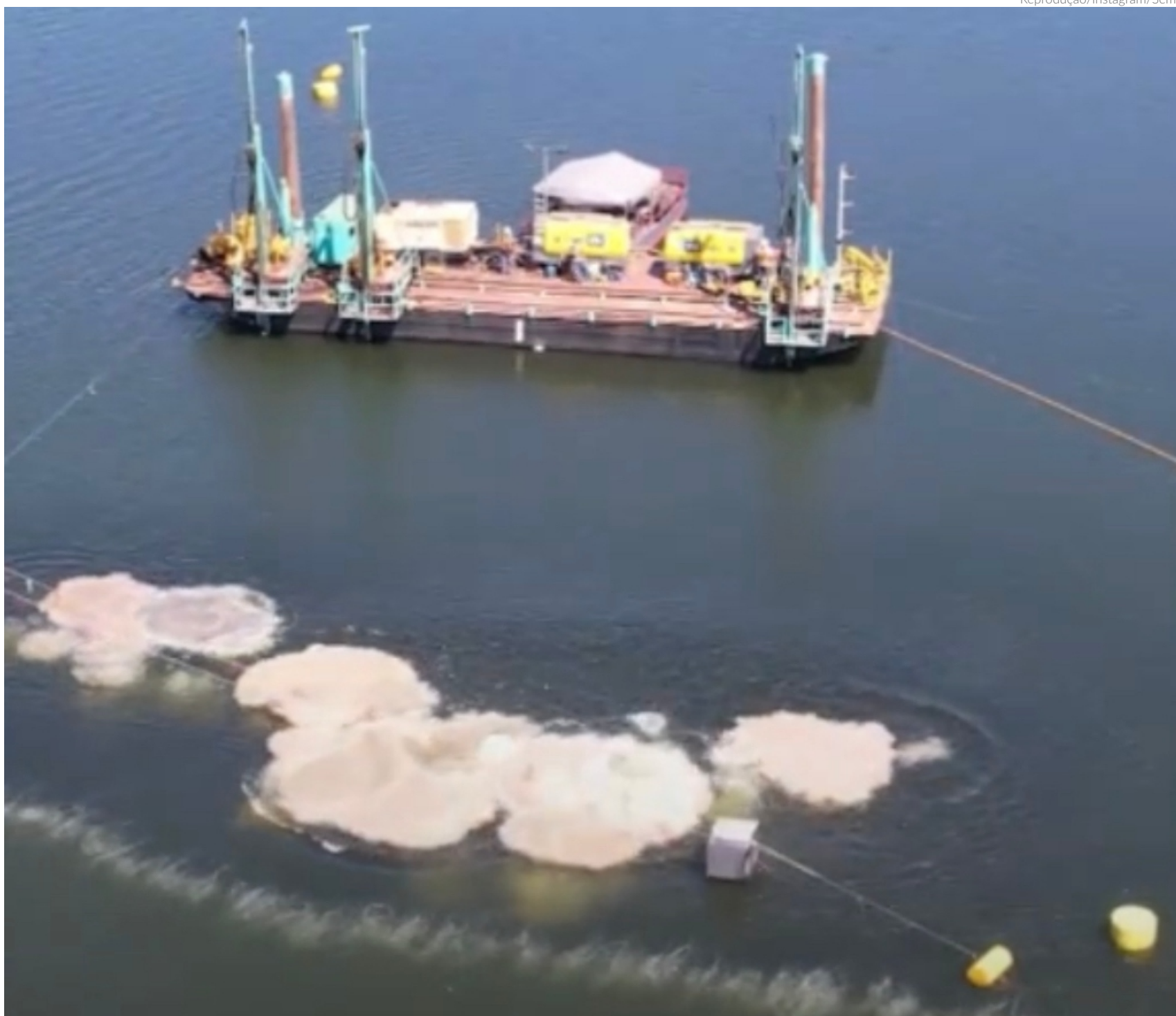
Com uso de balsas, são feitas perfurações no leito do rio em uma área de 24 metros quadrados; depois, usando um tubo guia, os explosivos são introduzidos nos furos
