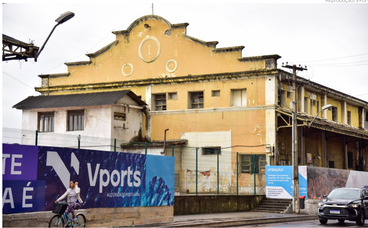
O projeto de reforma e recuperação dos prédios dos armazéns faz parte das obrigações do caderno de encargos da VPorts após o processo de desestatização da antiga Codesa
