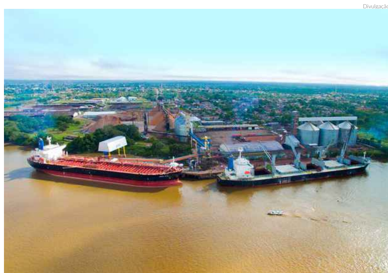
O terminal de Santana, destinado à movimentação e armazenagem de granéis sólidos vegetais, teve os EVTEA elaborados pela Infra SA e aprovados pela Antaq em junho
