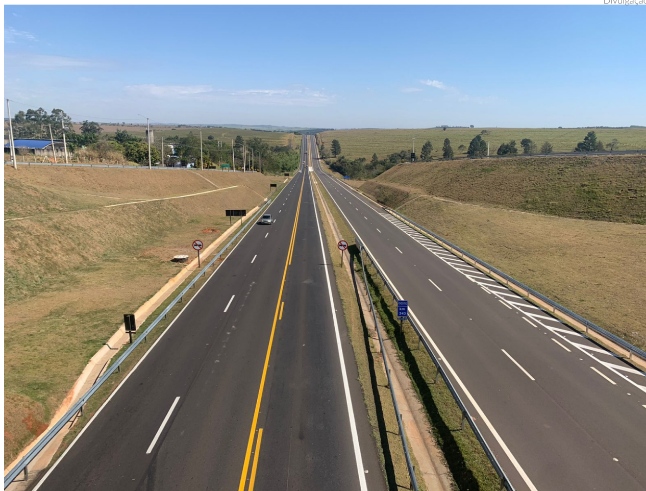
O projeto do Lote Litoral abrange a concessão de 213 km das Rodovias SP-055, SP-088 e SP-098, que conectam o Alto Tietê ao Litoral Sul, com duração de 30 anos
