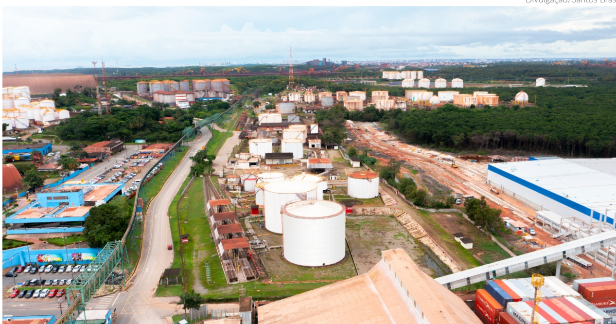
Os terminais de graneis líquidos têm conexões com modais rodoviário, ferroviário, dutoviário e marítimo, e o porto tem capacidade para receber navios de até 155.000 toneladas DWT
