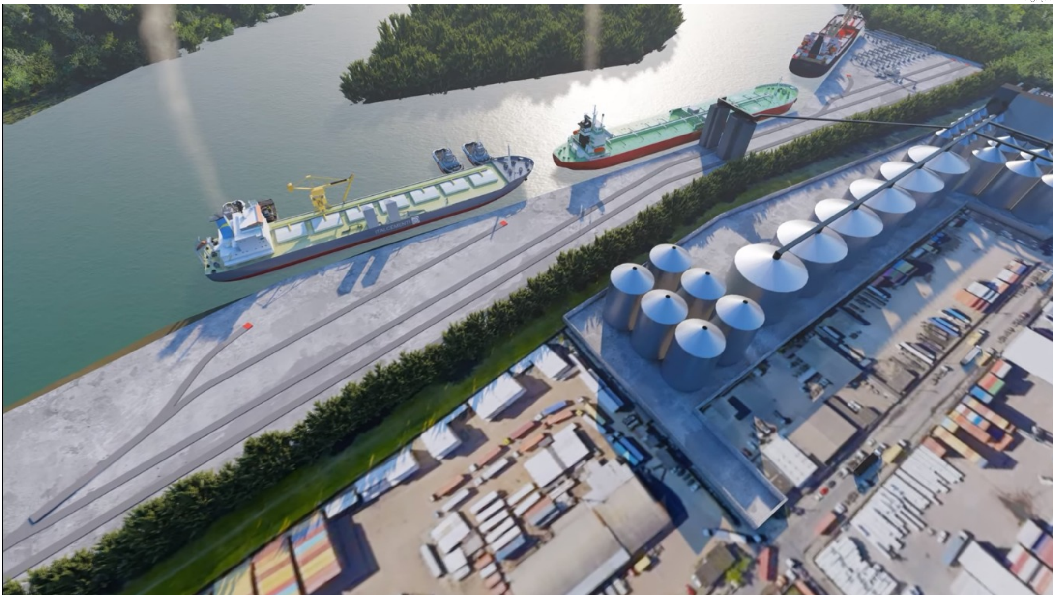
O empreendimento contará com três berços de atracação, três plataformas de operação, sistema de carga e descarga de grânéis líquidos em uma área total de 90 mil m 2
