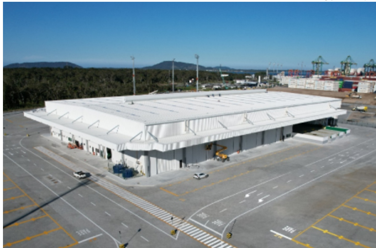
A estrutura compreende 12 portões laterais, três docas para caminhões com rampas niveladoras para operações crossdocking, 2.271 posições para pallets, entre outros itens
