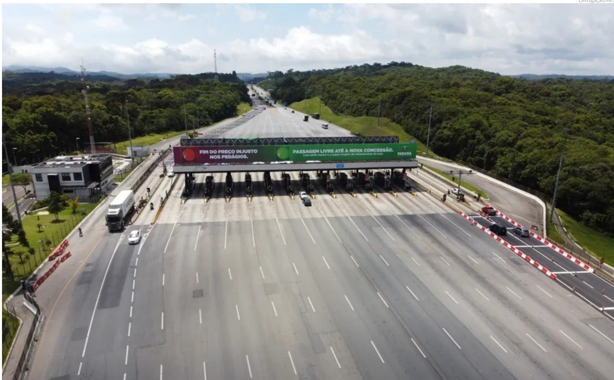
Os dois trechos englobam mais de 1,2 mil quilômetros, fazendo ligação de Curitiba, o Porto de Paranaguá, no litoral do estado, e os Campos Gerais às regiões Norte e Oeste
