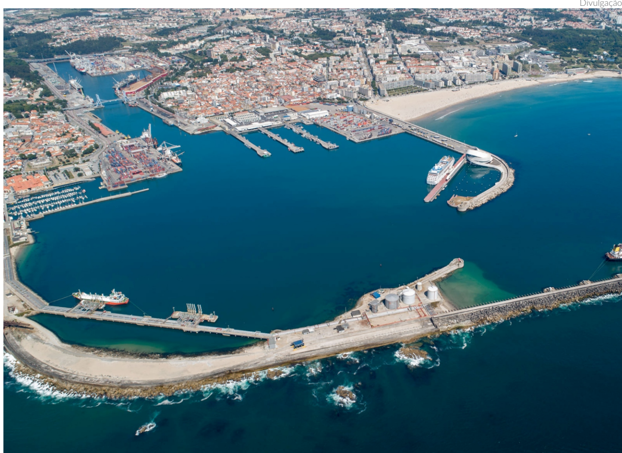
A reformulação e requalificação do terrapleno do Molhe Sul do Porto de Leixões e seus respectivos acessos, também fazem parte do plano de modernização e reordenamento
