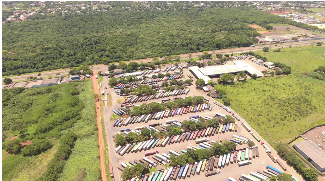
No quesito segurança, a Multilog informou que serão instaladas câmeras avançadas para vigilância interna e externa. Serão quatro gates de entrada de veículos e dois de saída
