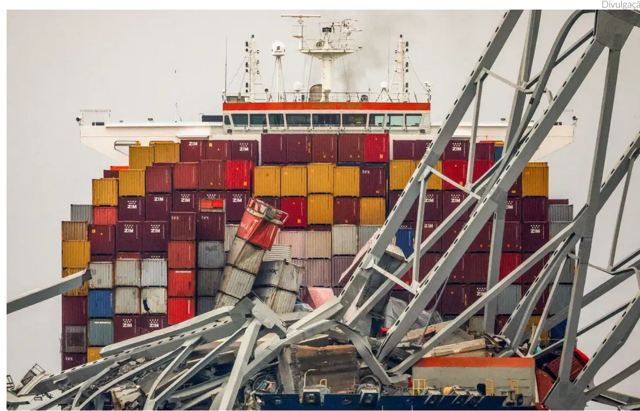
O cargueiro bateu na ponte após sofrer duas quedas de energia enquanto navegava pelo canal do porto. Investigações analisam se o uso de combustível impróprio causou o apagão
