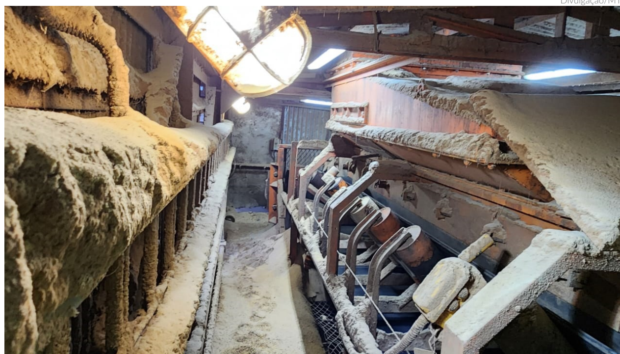
A esteira é um equipamento que faz o transporte principalmente de grãos para o embarque e desembarque do produto e desta vez só parte que participa do Estádio de Sá
