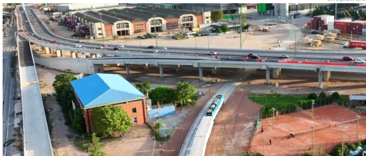
O desembarque da carga foi feito no novo terminal de celulose do Porto de Montevideu e toda a operação foi coordenada pelo Centro de Controle de Tráfego Ferroviário
