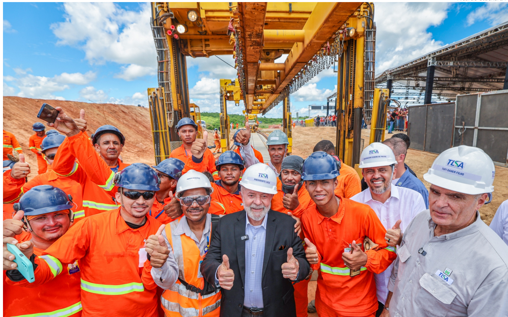
Lula posa para fotos com funcionários: o presidente reforçou que o compromisso da empresa é de concluir as obras da ferrovia no fim de 2026 ou no primeiro trimestre de 2027
