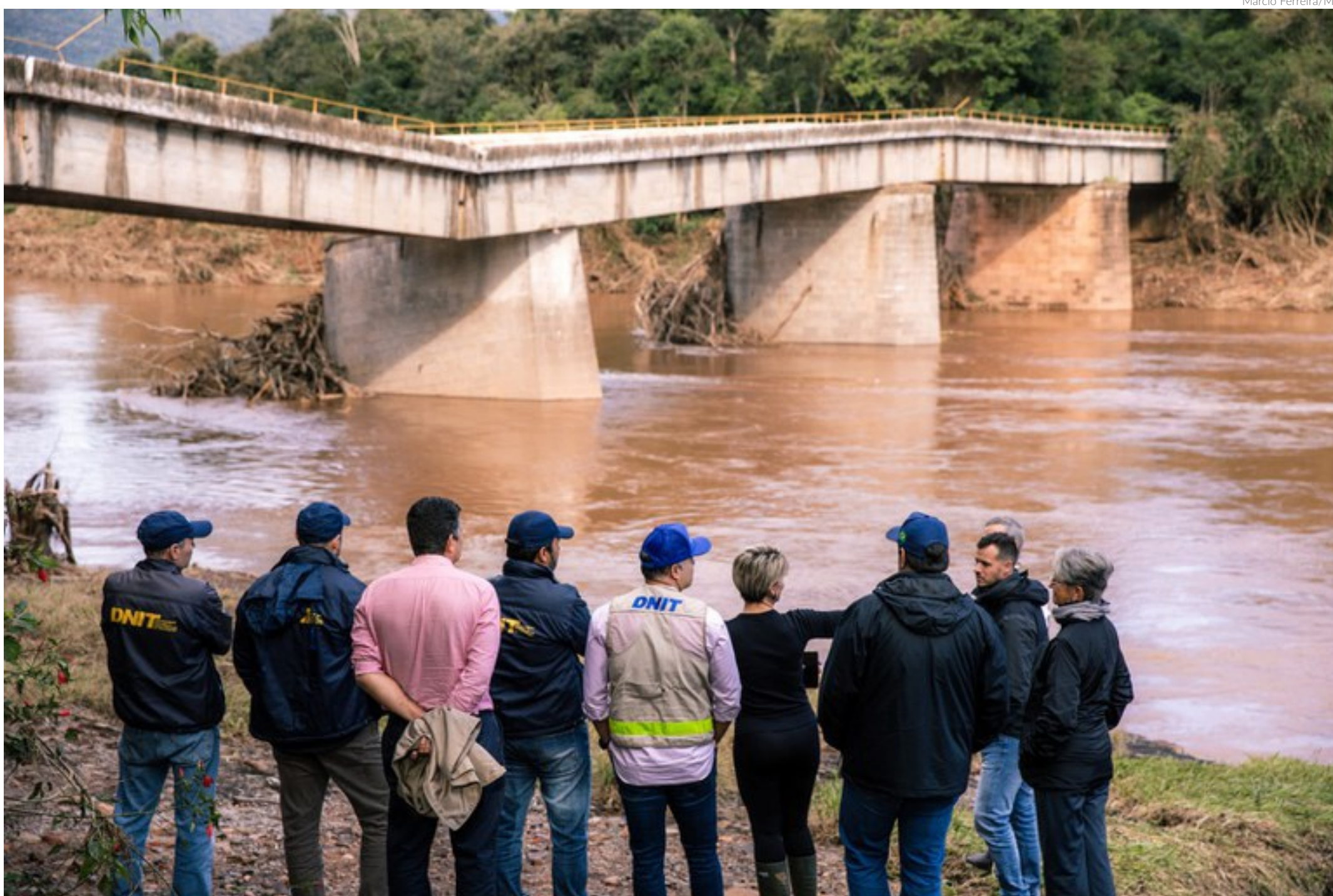
Renan Filho e sua comitiva visitaram a ponte que passa por sobre o Rio Caí, que sofreu um impacto em um de seus pilares e teve um deles derrubado, precisando ser interditada
