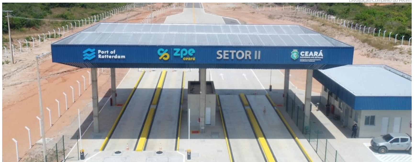
É no Setor 2 da ZPE Ceará, uma área de mais de 1.900 hectares, que serão instaladas as unidades fabris para a produção e distribuição de hidrogênio verde no Complexo do Pecém
