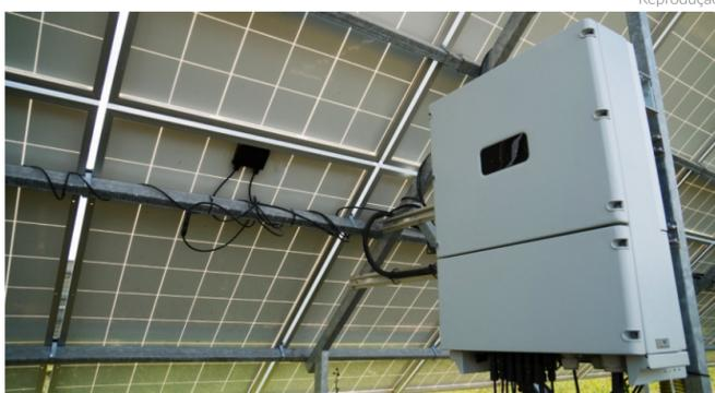
O inversor é um conversor que transforma a energia produzida pelos módulos solares de corrente contínua para alternada, para usar a energia solar produzida em aparelhos elétricos
