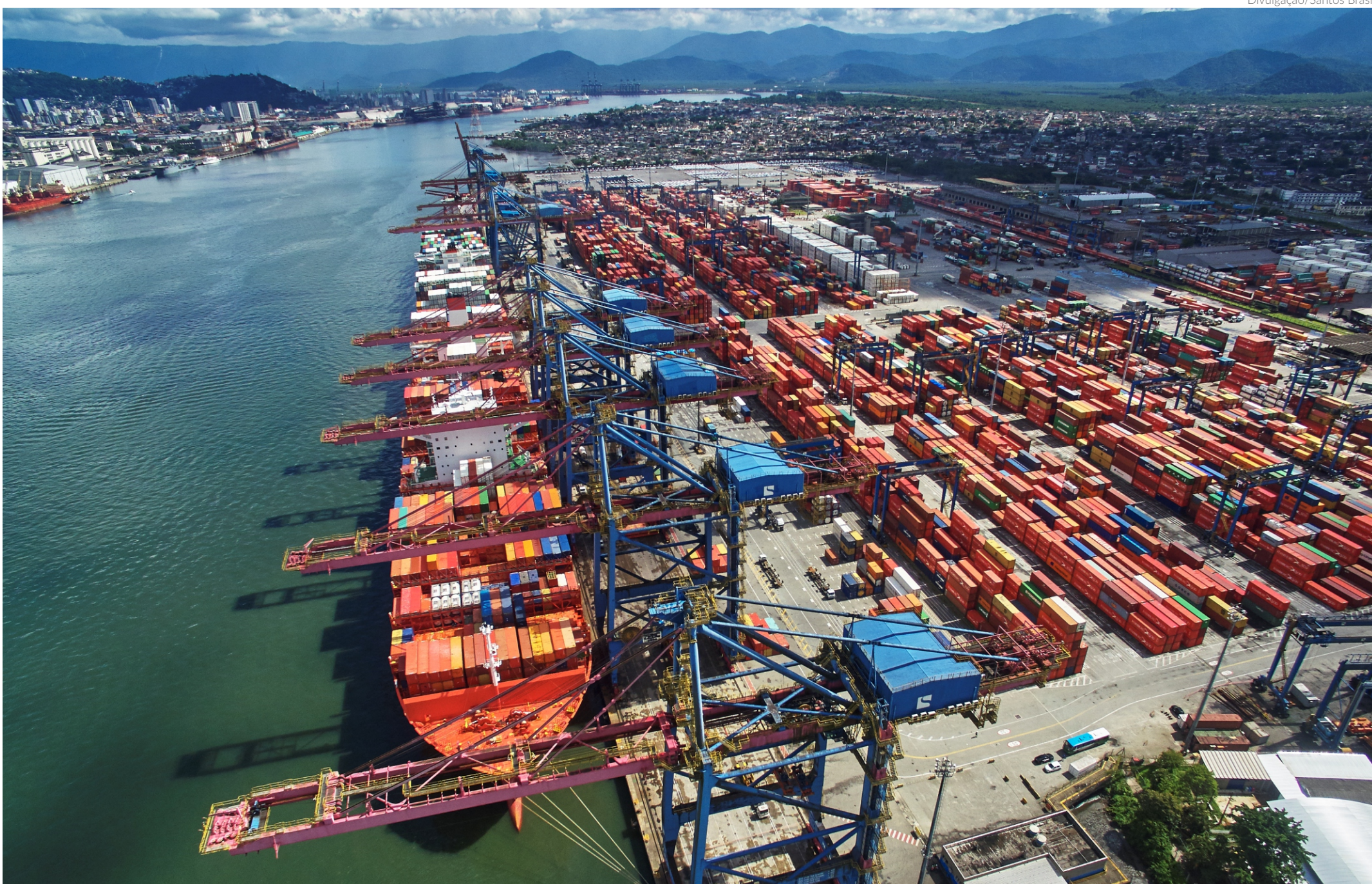
Só em 2024, cerca de R$ 420 milhões serão investidos no Tecon Santos, aumentando a capacidade do terminal dos atuais 2,4 milhões de TEU para 2,6 milhões até o final do ano
