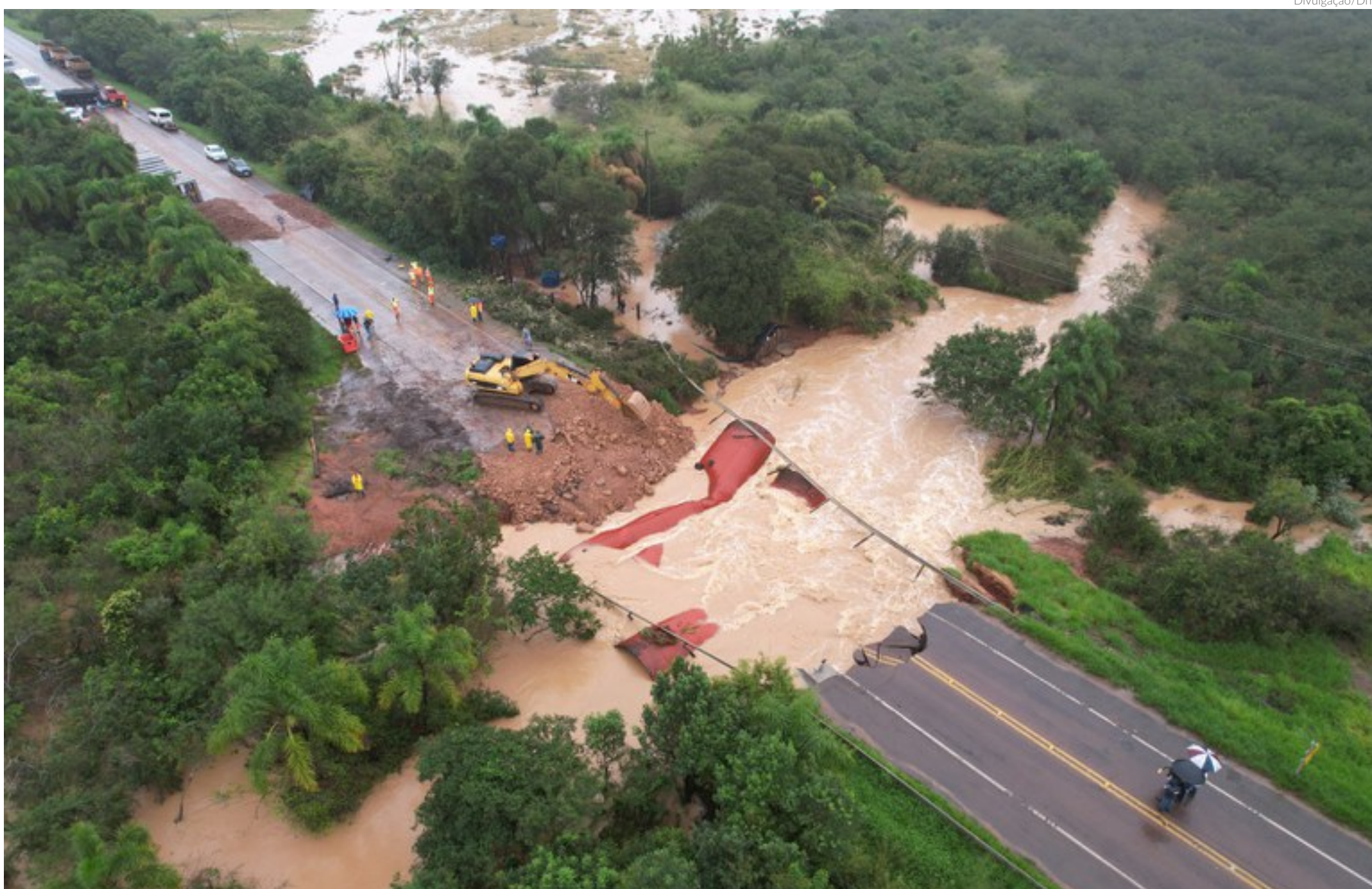
No período mais grave das enchentes, entre abril e maio, o Rio Grande do Sul chegou a ter 75 trechos de 44 rodovias com bloqueios totais ou parciais, entre estradas, pontes e balsas
