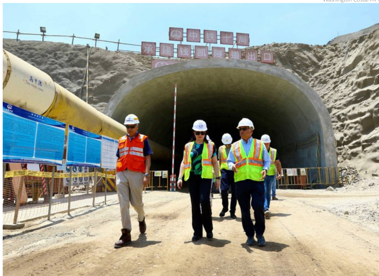
Em março deste ano, uma comitiva do Governo Federal, liderada pela ministra do Planejamento e Orçamento, Simone Tebet, visitou as obras do porto de Chancay, no Peru
