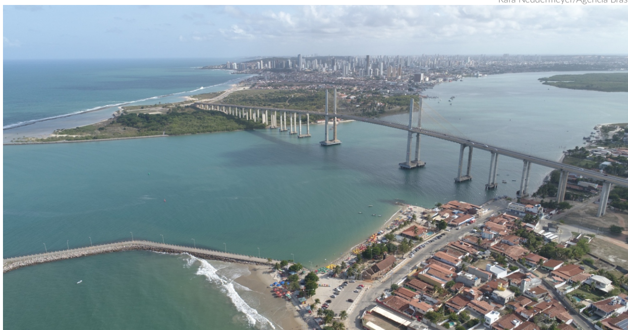
A obra de construção das defensas dos pilares centrais da Ponte Newton Navarro será executada em ação conjunta dos ministérios dos Transportes e de Portos e Aeroportos
