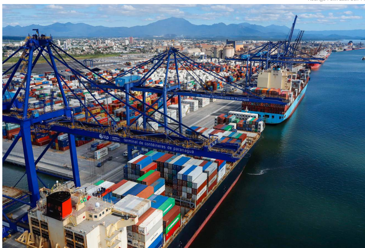
Canal de acesso ao Porto de Paranaguá: a expectativa é de que o leilão de concessão seja realizado em 2025, mas o Governo está otimista quanto à antecipação para este ano
