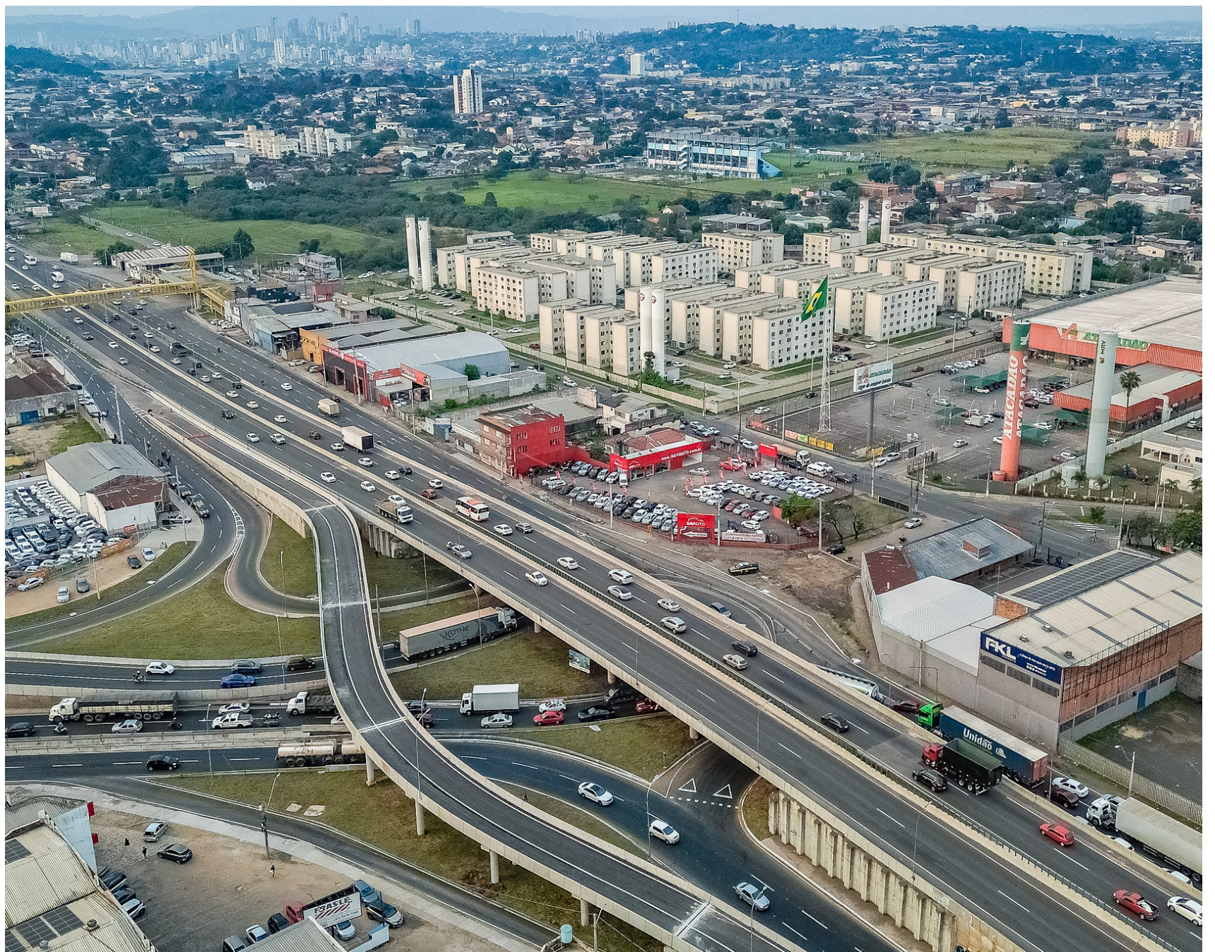
O Complexo de Viadutos da Scharlau, em São Leopoldo, inclui duas novas alças e o alargamento das pistas de acesso, ampliando a capacidade de fluxo de veículos no viaduto
