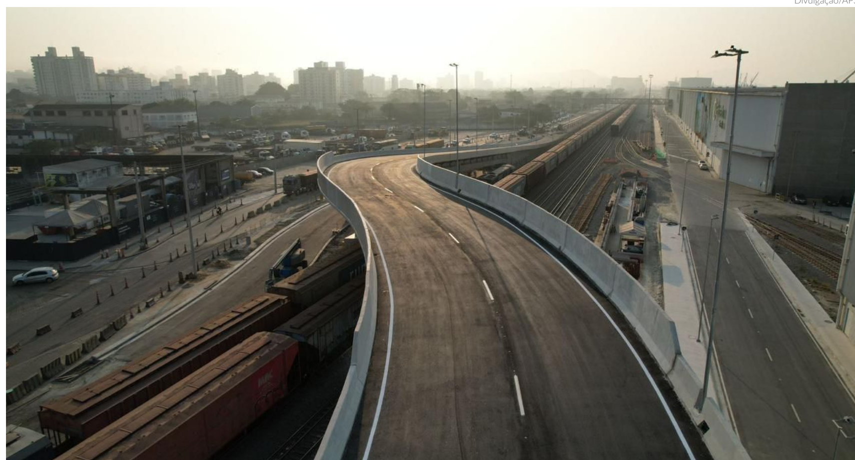
O viaduto recém-inaugurado tem 350 metros de extensão, nove metros de largura e duas faixas, com mão única para a Avenida Perimetral, sentido Ponta da Praia-Centro
