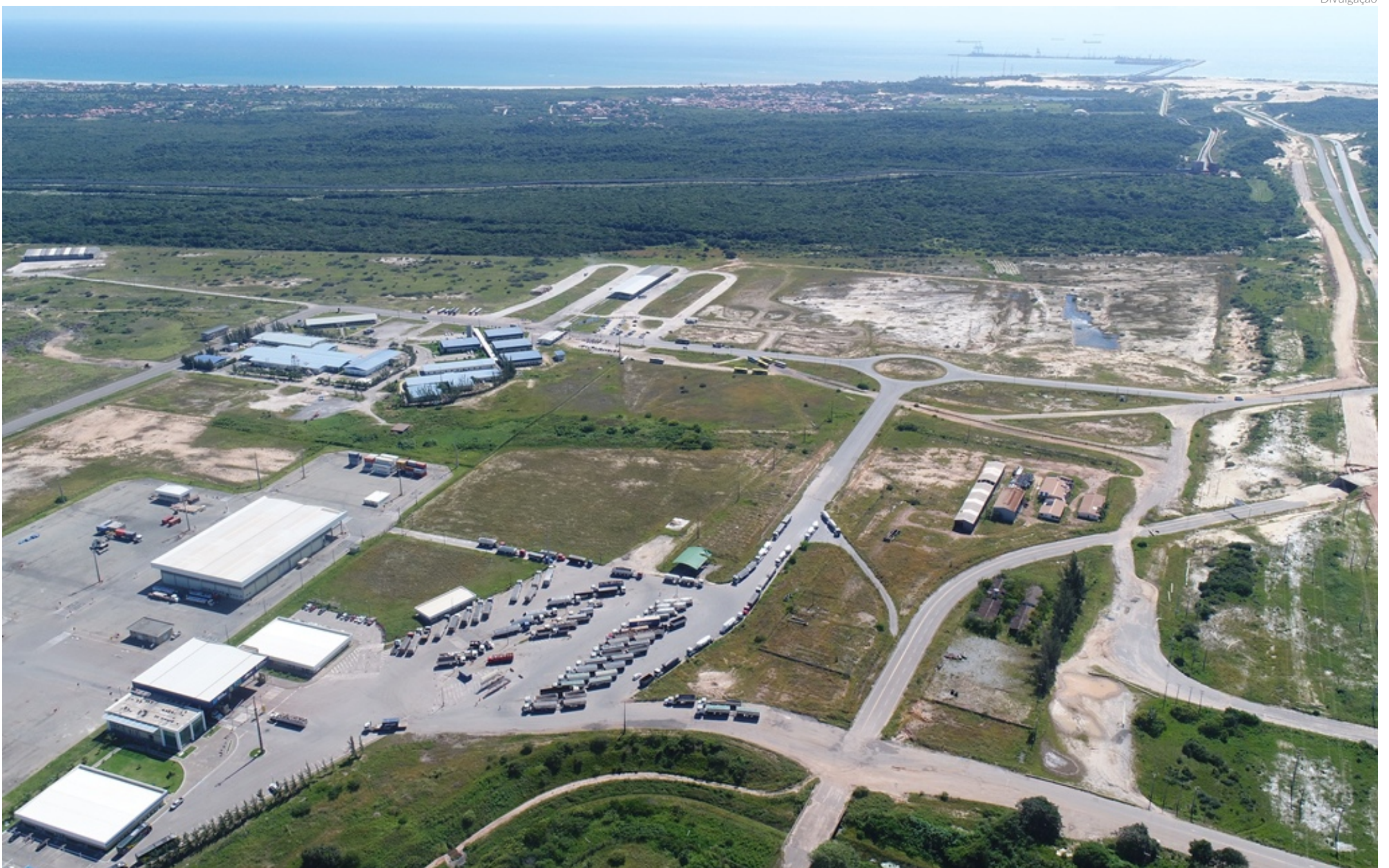
O início das atividades da ZPE Ceará foi em agosto de 2013. Três anos depois, foi exportada a primeira placa de aço produzida na siderúrgica instalada no Setor I do complexo
