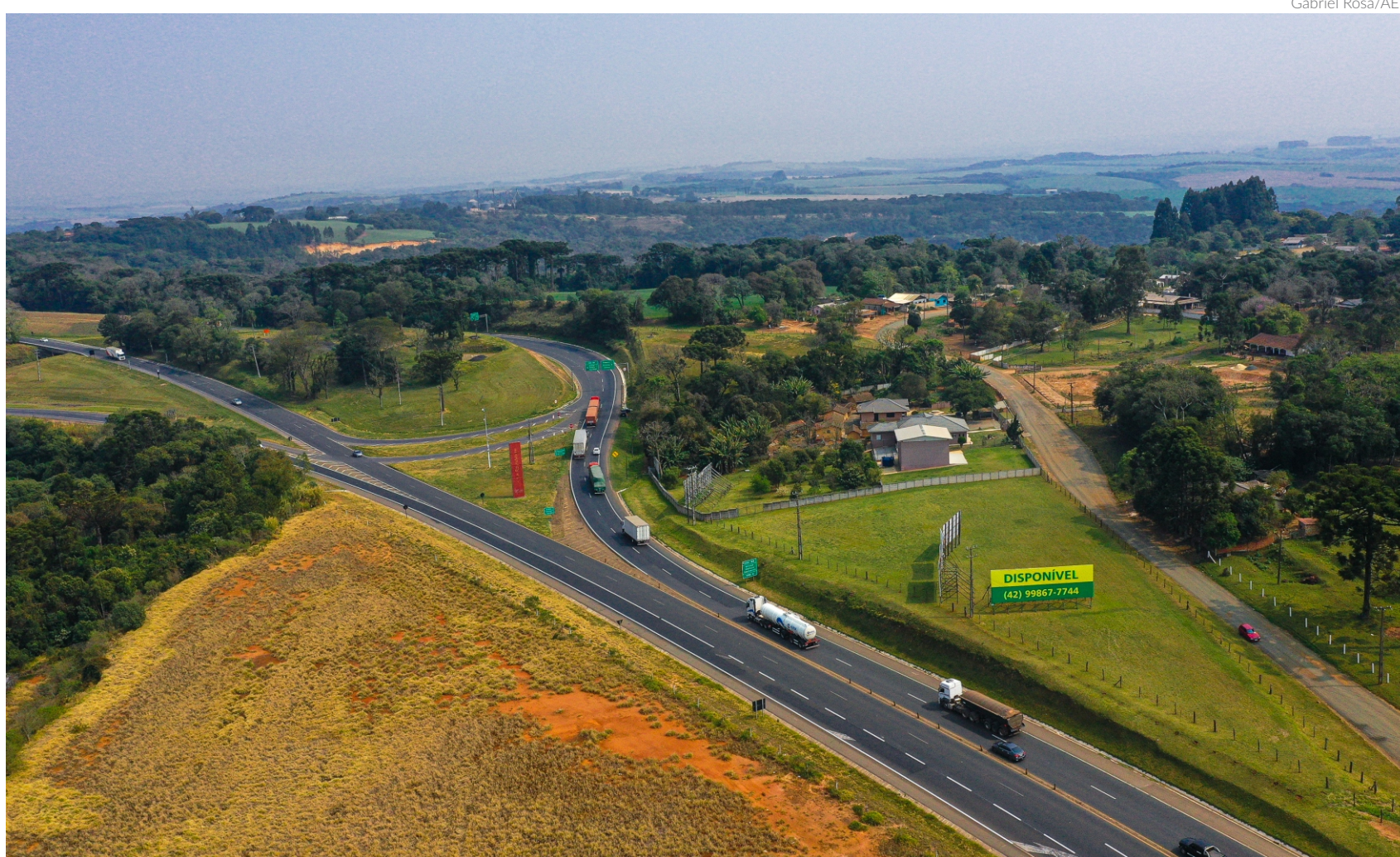
O Lote 3 cobre 569,7 quilômetros de rodovias, conectando trechos como Mauá da Serra a Londrina e Sertãoópolis e também interligando o Paraná a Santa Catarina e São Paulo
