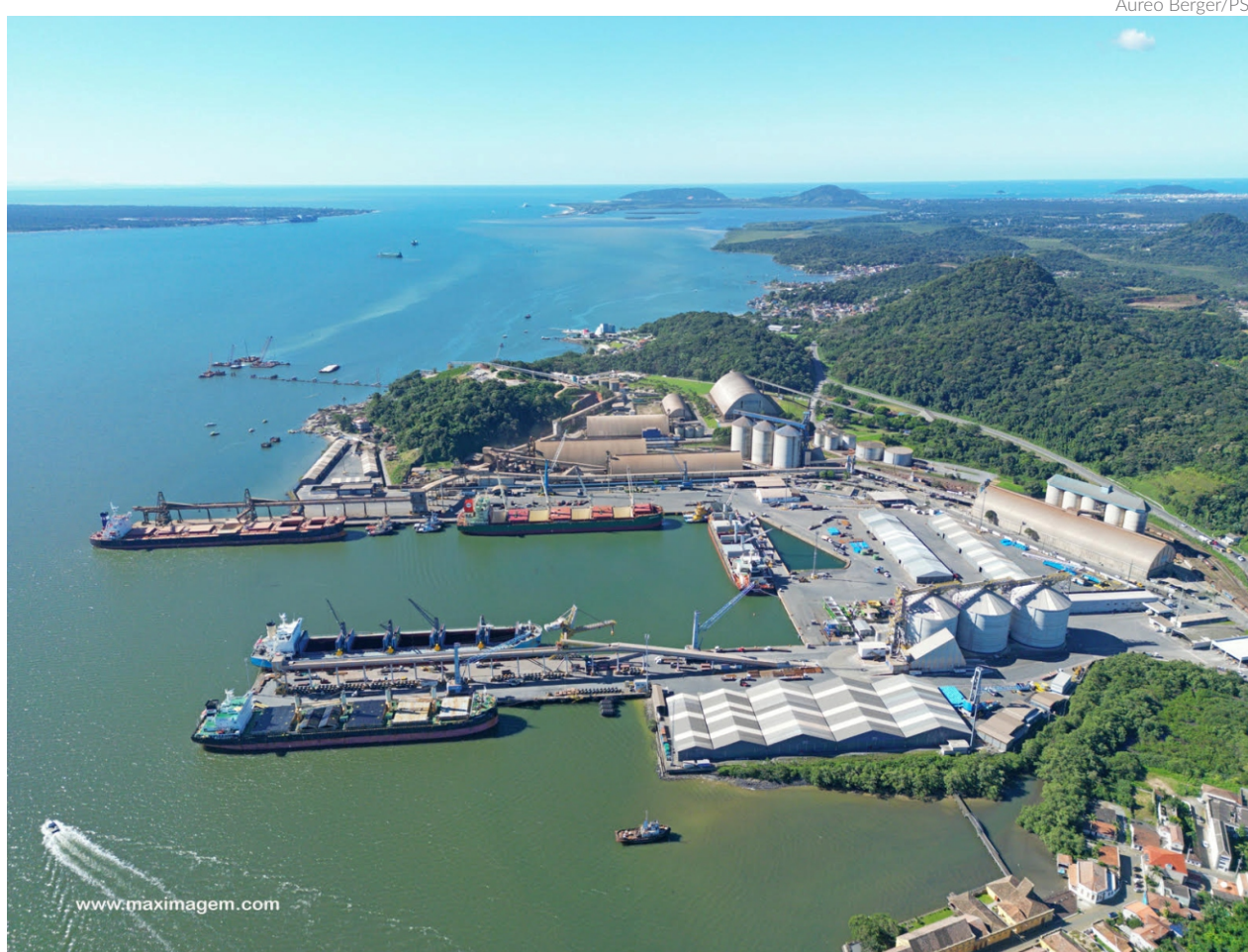
O serviço de dragagem autorizado pelo Ibama irá favorecer o complexo de São Francisco do Sul e o Porto Itapoá, terminal privado de contêineres localizado na Baía de Babitonga
