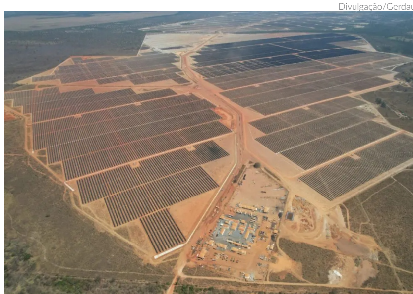
Usina solar na cidade de Arinos (MG), a primeira da Newave Energia: a unidade de Goiás terá capacidade de 452 megawatt-pico (MWp) e deve entrar em operação no início de 2026
