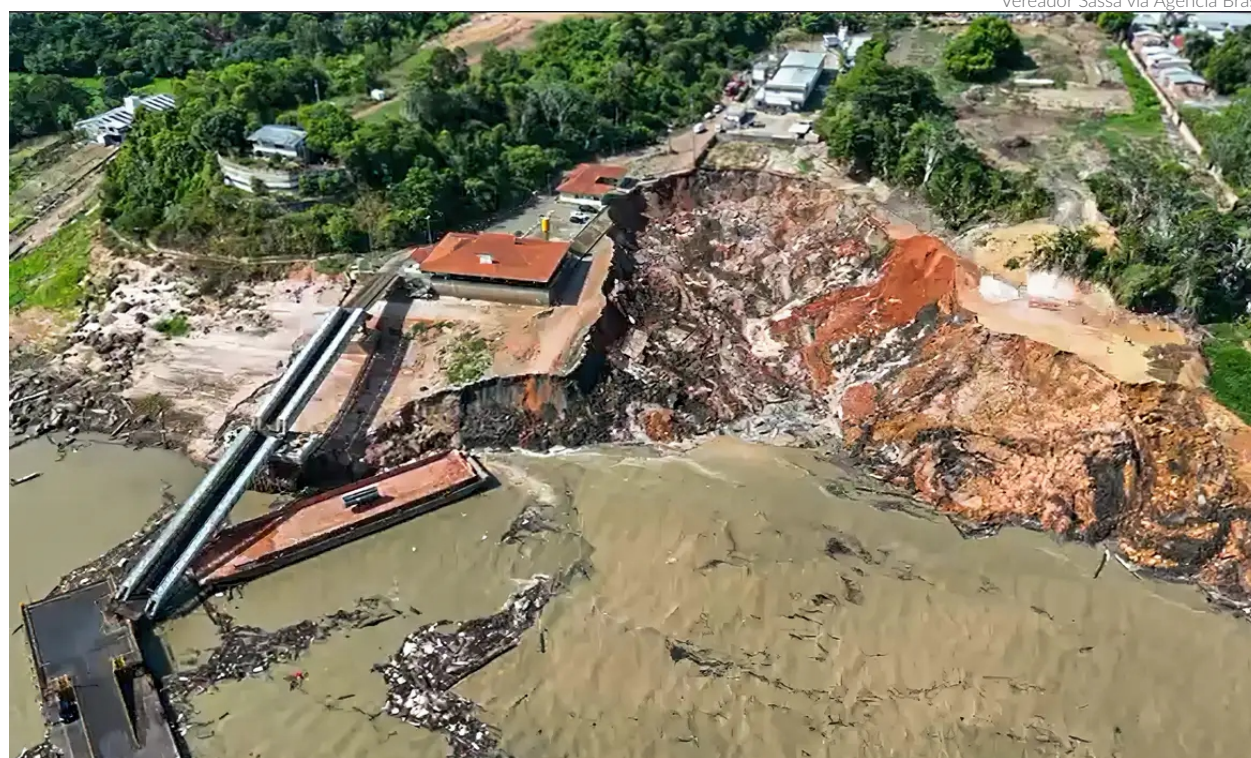
O Porto da Terra Preta, que abriga o Terminal Hidroviário e a Secretaria Municipal de Pesca, é um ponto estratégico que liga Manacapuru a outras localidades do interior do Amazonas
