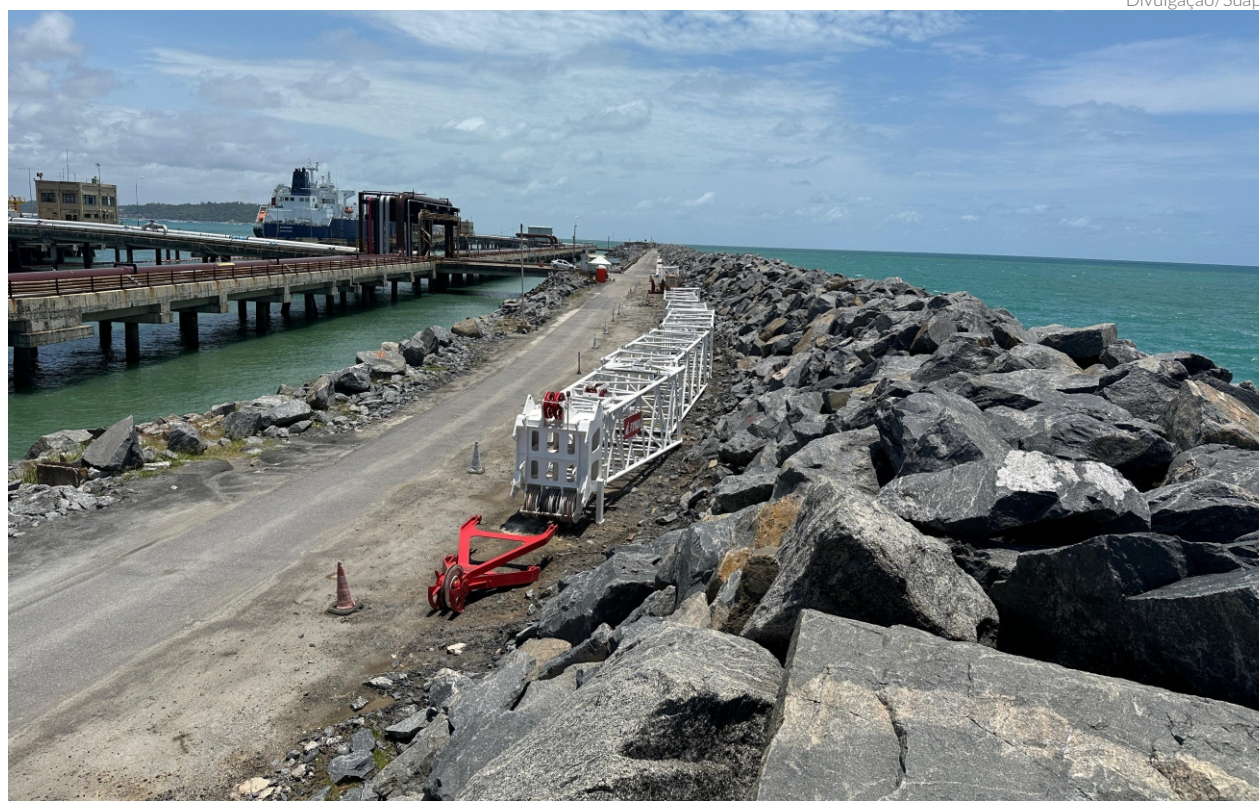
As obras referem-se à recomposição do prolongamento do molhe de abrigo do Porto de Suape, que sofreu danos significativos na berma hidráulica ao longo dos últimos anos
