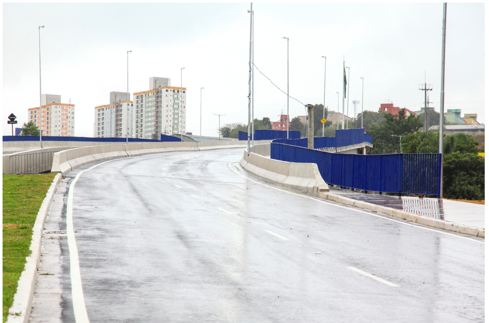
Além de melhorar o trânsito e garantir mais segurança no transporte local, os viadutos entregues também têm o objetivo de desafogar o tráfego na região central de Carapicuíba
