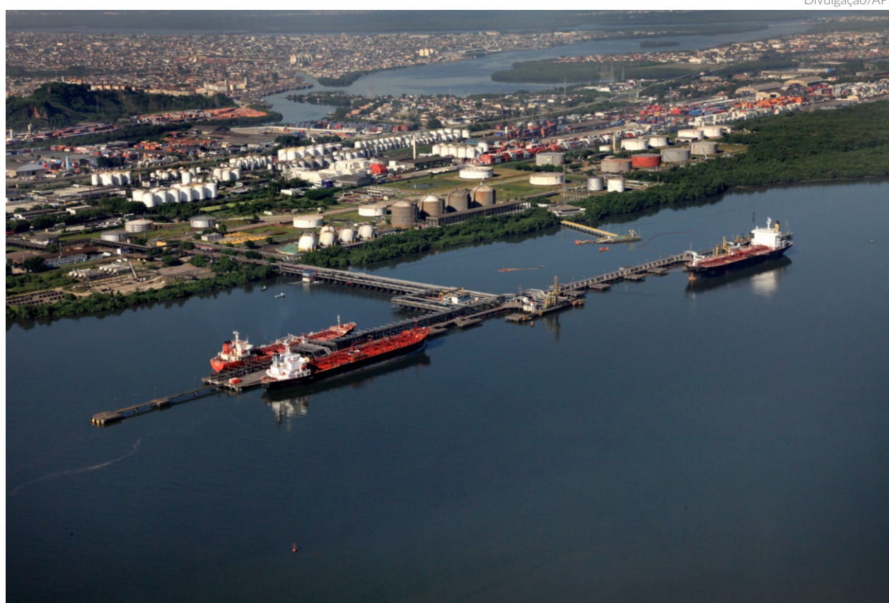
De acordo com a APS, estão previstos no STS08 quatro novos berços e mais tanques de armazenagem, além de ter conexões com dutovias, rodovias e píeres na margem direita
