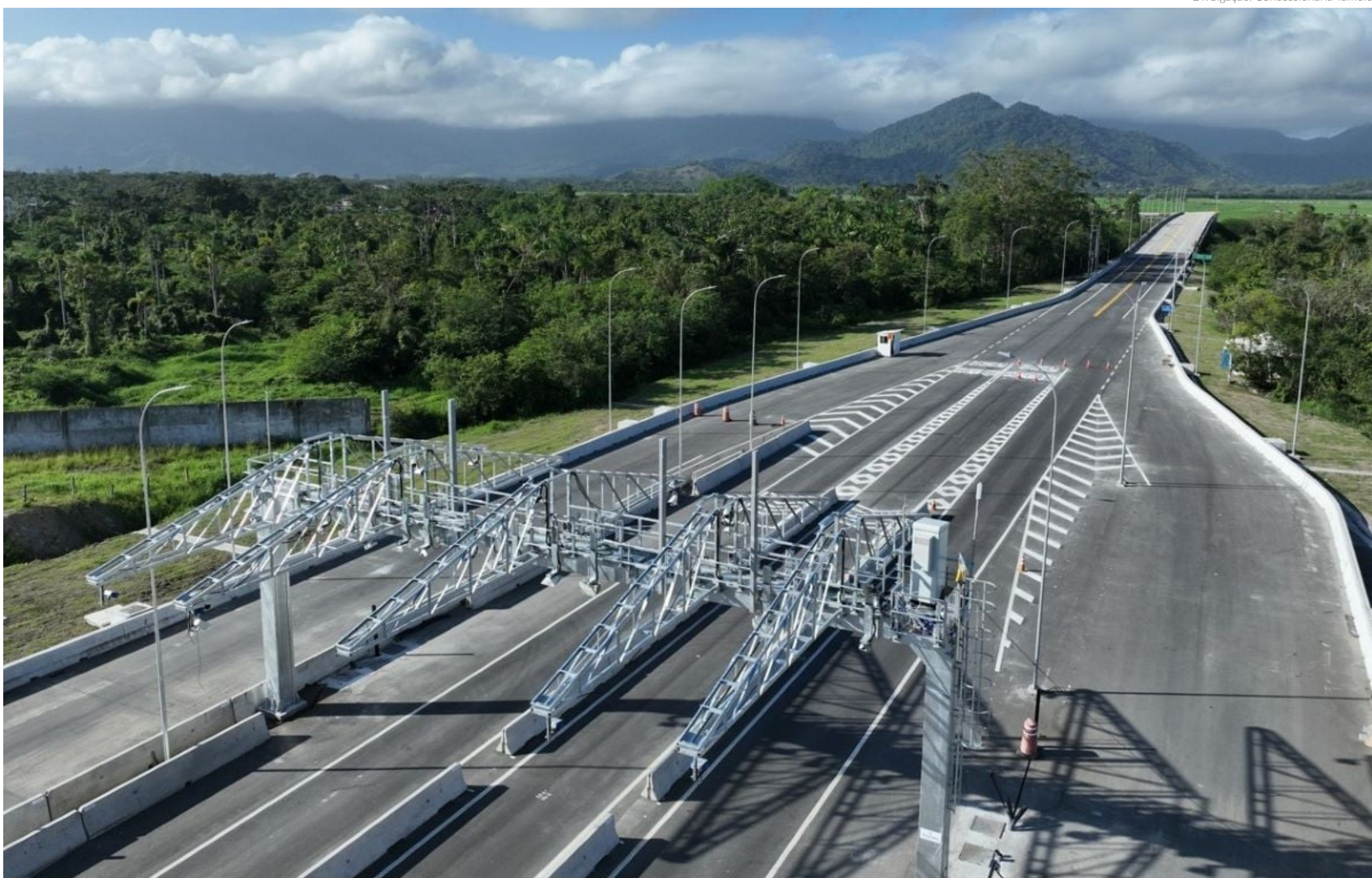
De acordo com a concessionária, o Contorno Sul vai ligar o Km 11 até o Km 33 da rodovia dos Tamoios. O novo trecho terá quase 23 km de extensão e três túneis, em cada sentido
