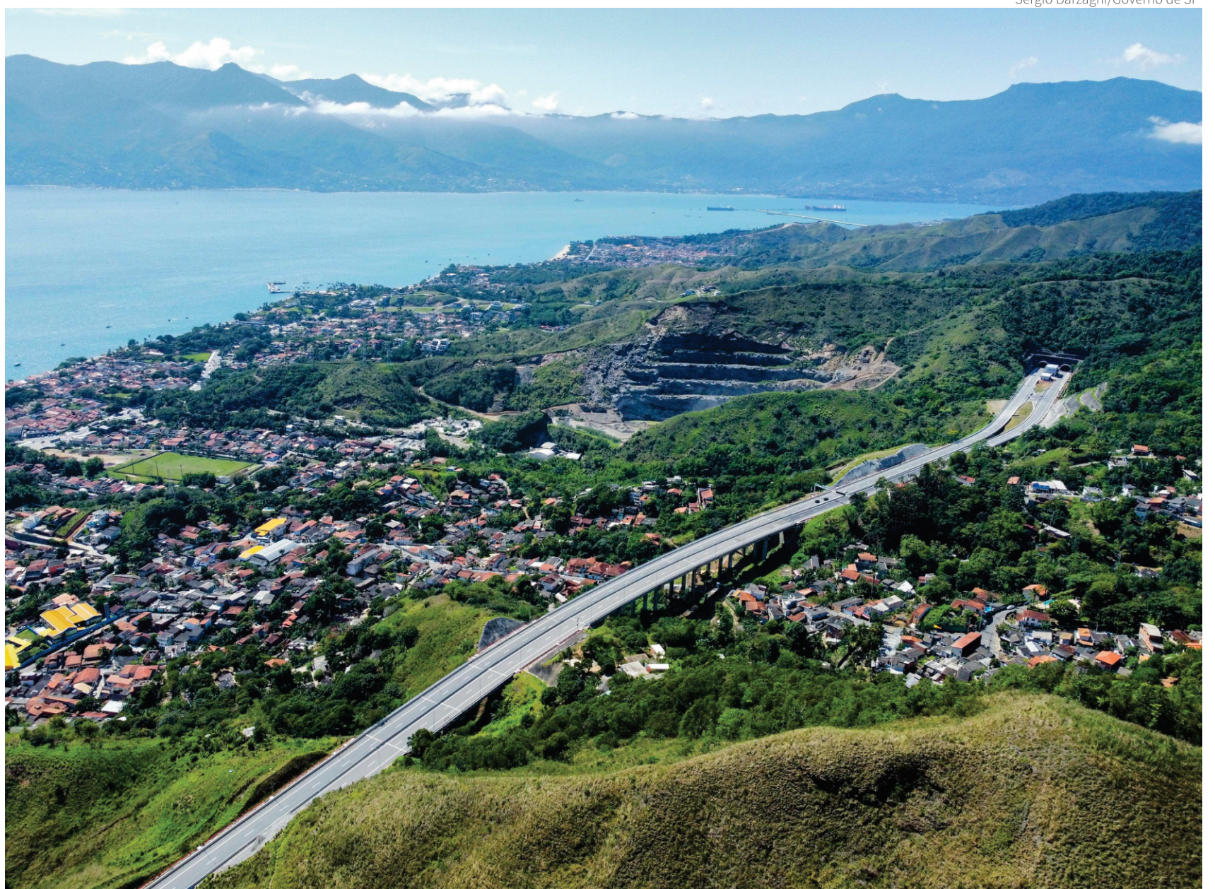
Com 22,7 km de extensão, o Contorno Sul tem seis túneis, três em cada sentido, que atravessam a Serra do Mar. O trecho conta também com 24 obras de arte especiais
