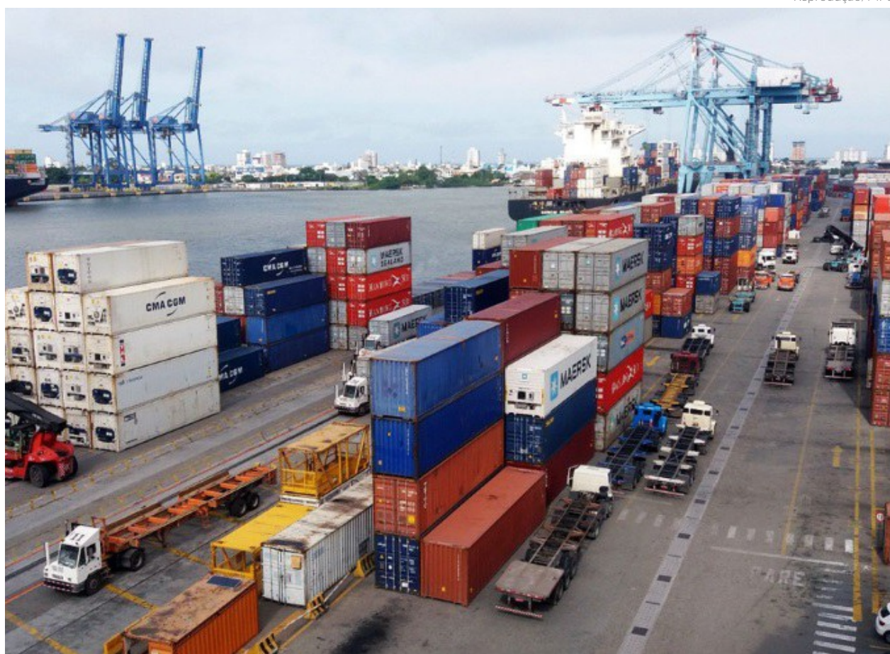
A municipalização do porto enfrentou crises nos últimos dois anos, com destaque para paralisações nos serviços de dragagem e dificuldades em arrendamentos temporários
